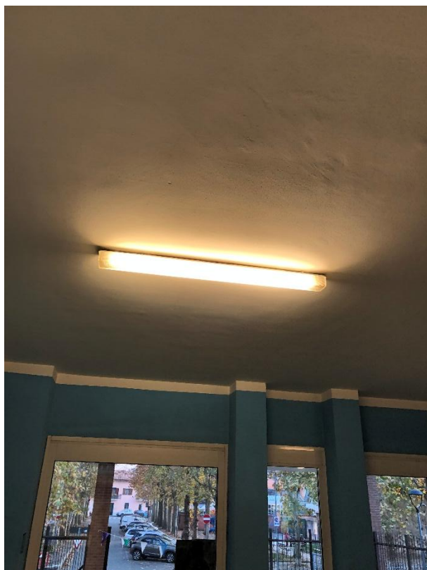
Figura 9 - Plafoniera neon a fluorescenza con 1 tubo da 1,20 m nel vano scale 1
