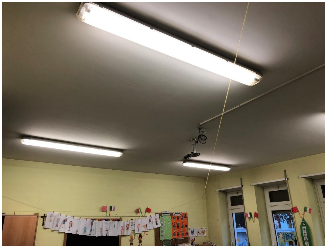
Figura 7 - Plafoniera neon a fluorescenza con 2 tubi da 1,50 m nell'aula 6
